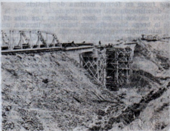
Puente Huaquén, vista de sur a norte
